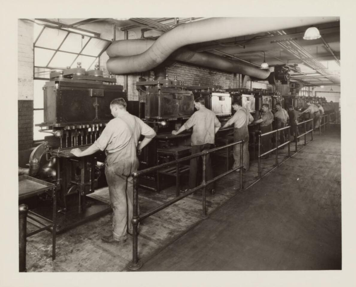
MULTIPLE SPINDLE DRILL PRESSES
